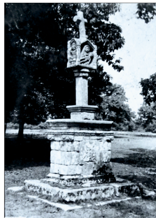
Vue générale sud-est en 1921 ; cl. G. Estève, Ministère de la Culture - Médiathèque de l'architecture et du patrimoine - diffusion RMN
