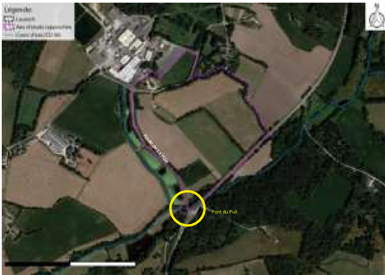
94 Localisation du franchissement de la voie communale de la Haie (source : Quarta ; BDD CD 56 ; fond : Google satellite)
