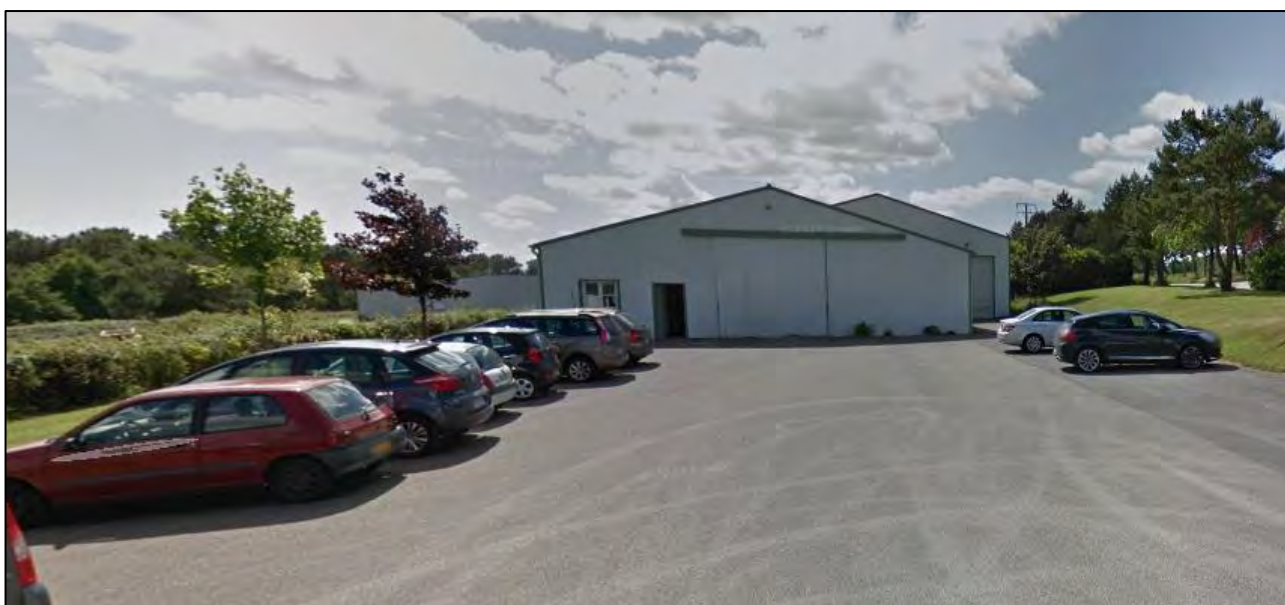
Bâtiment ouest du site de Sulniac.
