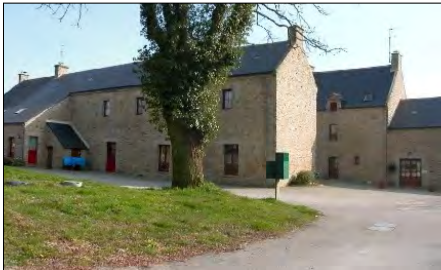
L'ancienne ferme de Bobéhec réhabilitée en gîte communal
