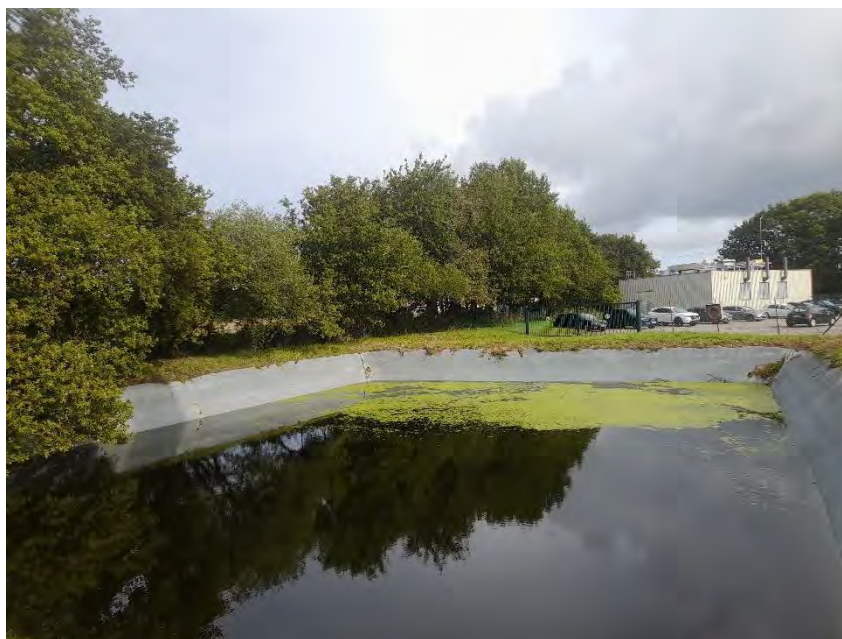
Photo N°21: Bassin de gestion des eaux pluviales localisé à l'Est du site (hors périmètre), le 09 septembre 2025
