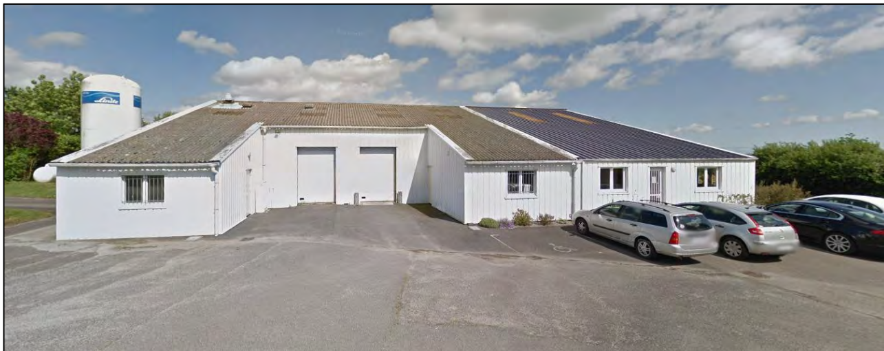
Bâtiment est du site de Sulniac.
