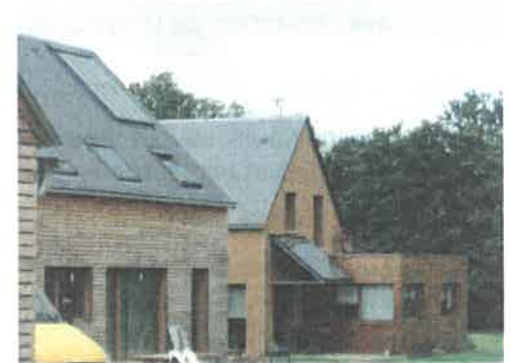
Langouët (35)- Arch : Menguy Intégration architecturale des équipements techniques
