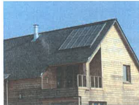
La Vraie Croix (56) : Panneaux intégrés à la toiture
