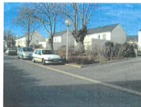
Angers (49) : garage dissocié pour dégager un jardin Sud en façade avant
