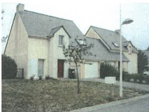
La Chapelle-sur-Erdre (44) Raccord de toitures mitoyennes maîtrisé
